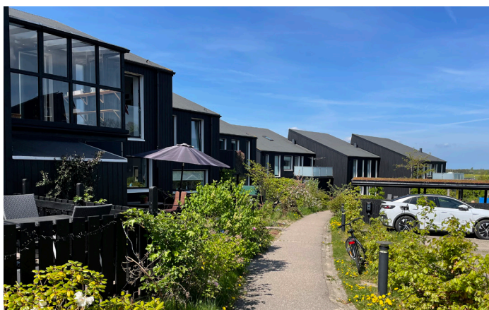
Bebyggelse der trapper ned i takt med terrænet, hvilket understreger landskabet og begrænser terrænregulering.
