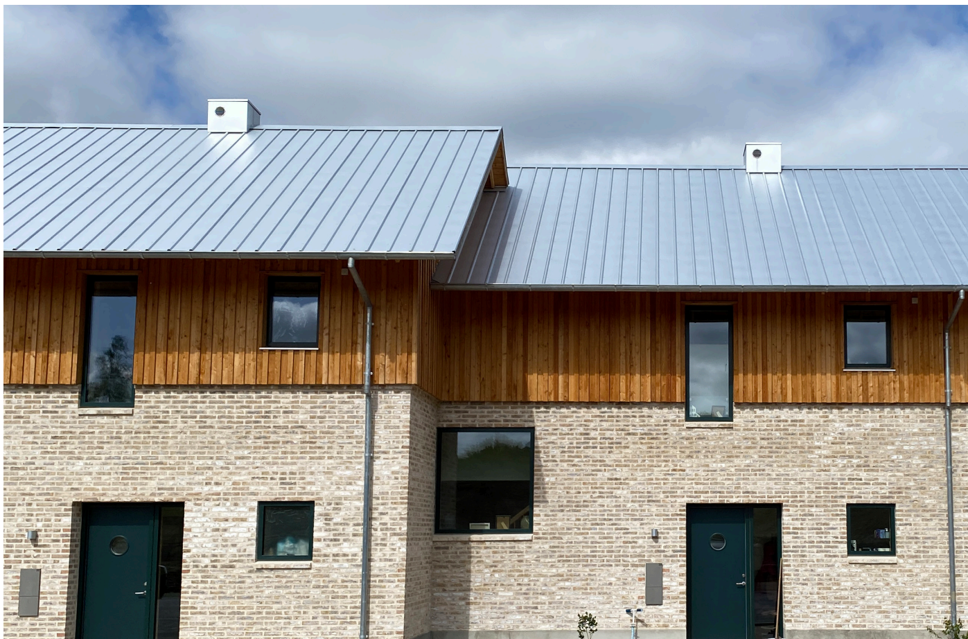
Mølholm Skovhusene, Ulvehavevej i Vejle: Kombination af teglsten og træ på facaden. Forskydninger i bebyggelsen bryder tagfladen, og gør at bebyggelsen lægger sig på det naturlige terræn.
